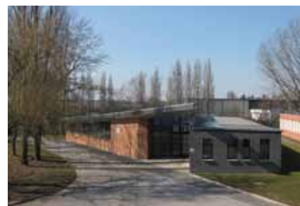
Le nouveau bâtiment réservé aux Réseaux et Télécommunication, inauguré peu avant l'Assemblée des Chefs de Département.
