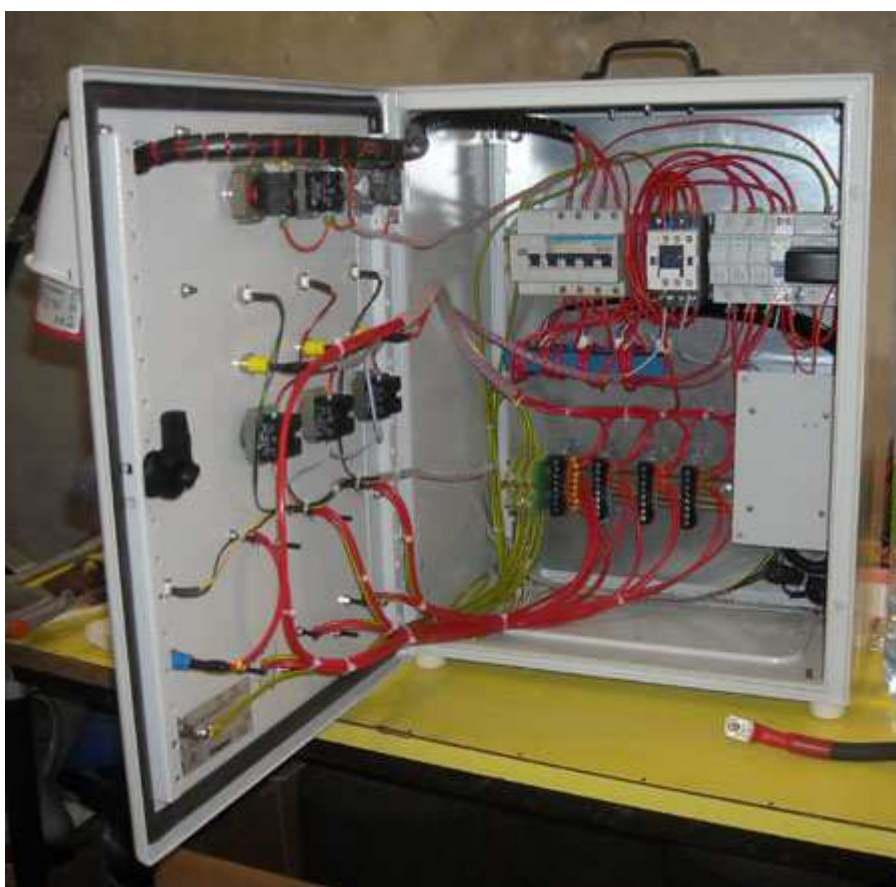
Fig. 7.2. Armoire triphasée 400V 16A (images-composants\bornier1.jpg).
